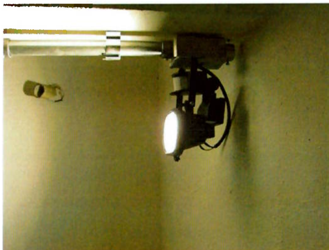
Foto 6.2 – Luminária à prova de explosão instalada na garagem subterrânea do posto.
