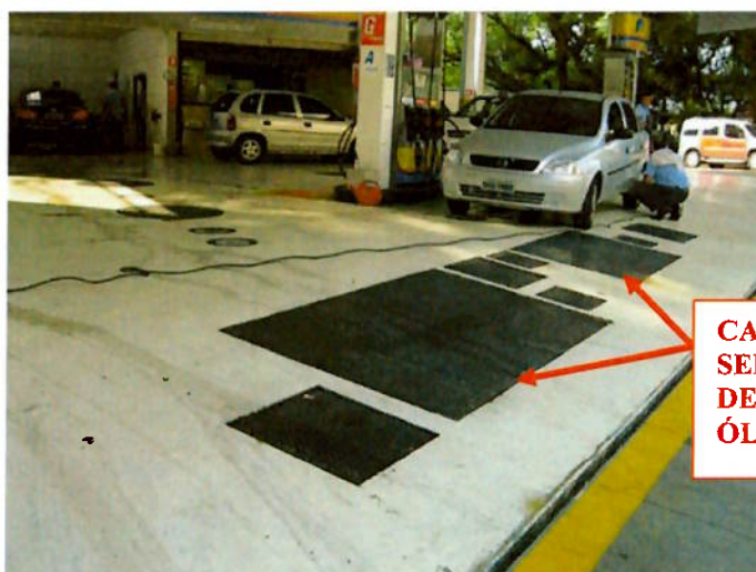
Foto 5.10 – Locais onde estão instaladas as caixas de retenção de sólidos (06 tampas menores) e as caixas separadoras de água e óleo (02 tampas maiores). Estes equipamentos estão instalados dentro de câmaras de contenção, que evitam a contaminação do solo em caso de vazamentos.
