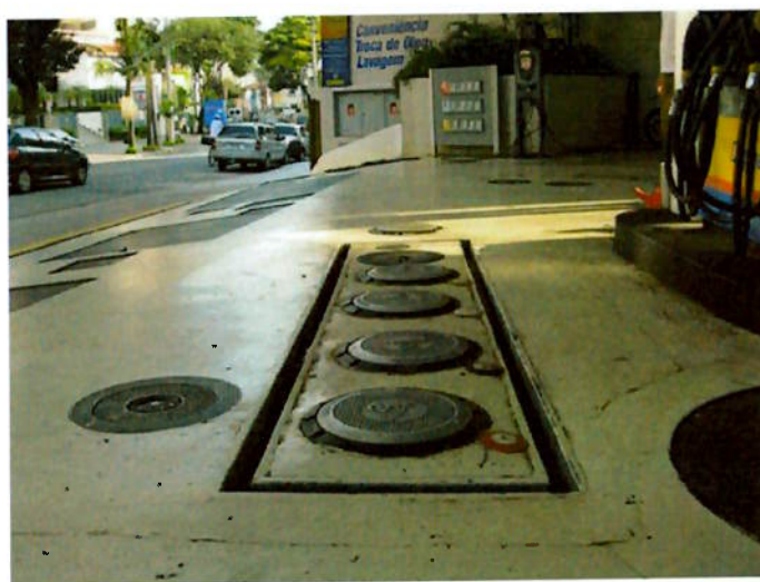
Foto 5.6 – Área do posto onde estão localizados os bocais de carregamento à distância. Canaleta de contenção ao redor da área.
