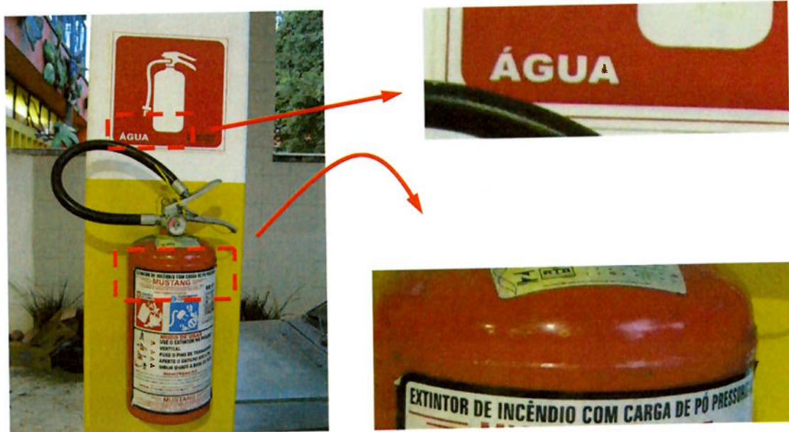
Foto 5.13 – Placa indicando extintor de tipo diferente ao encontrado na parede
