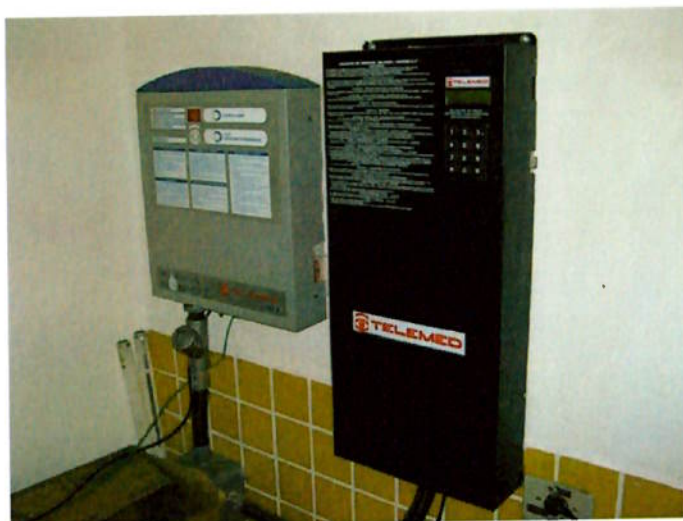
Foto 5.2 – Equipamento de monitoramento dos sensores do posto (à esquerda) e equipamento de controle de estoque subterrâneo de combustível (à direita)
