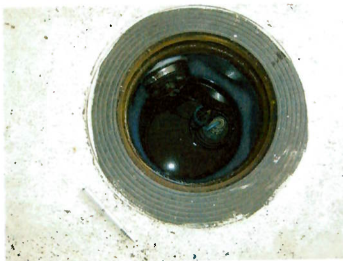
Foto 5.1 – Sensor intersticial de um dos tanques de parede dupla
