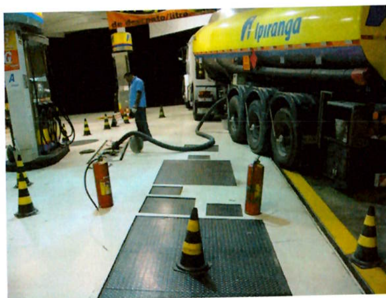
Foto 5.15 – Extintores de pó químico de 12 kg colocados na área
