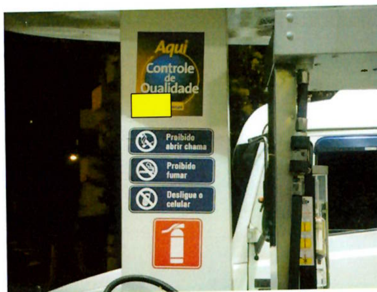
Foto 5.12 – Placas de advertência afixadas nas ilhas de abastecimento
