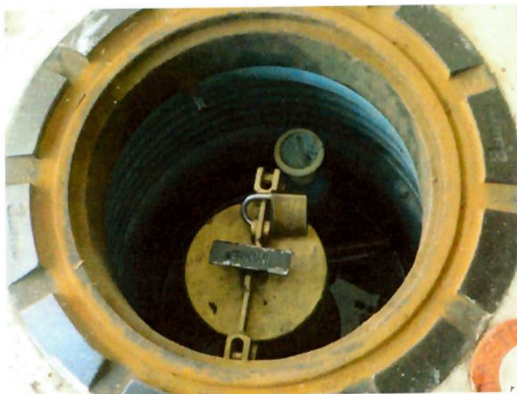
Foto 5.5 – Bocal de carregamento com tampa e trava (cadeado)
