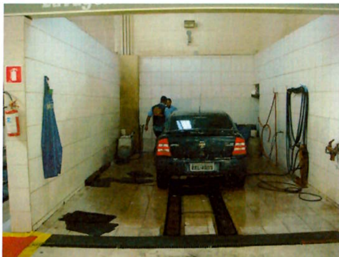
Foto 5.9 – Grelhas de contenção para a área de lavagem
