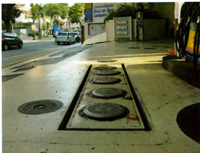
Foto 6.1 – Irregularidades no piso na área dos bocais de carregamento à distância (observar, à direita, a localização da unidade de abastecimento)
