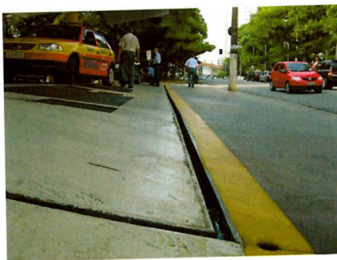
Foto 5.8 – Canaletas de contenção para a área de abastecimento
