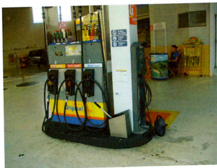
Foto 5.7 – Grupo de três bombas do posto, sob as quais está instalado o sump
