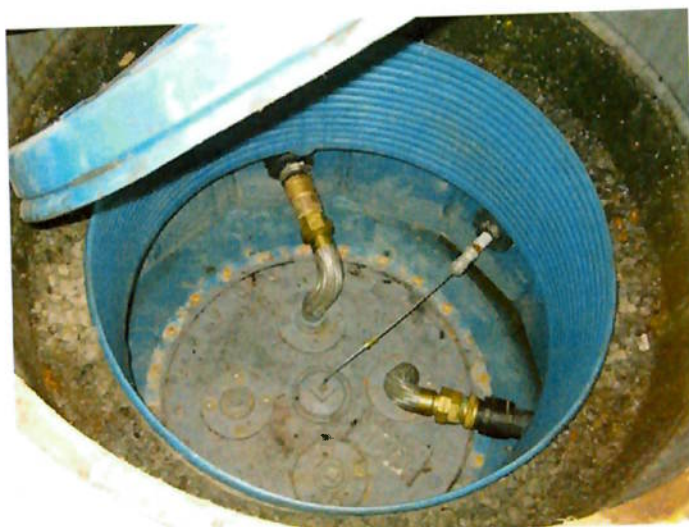
Foto 5.3 – Câmara de acesso à boca de visita de um dos tanques. Os tubos metálicos flexíveis mostrados na foto estão conectados com as bombas de combustível
